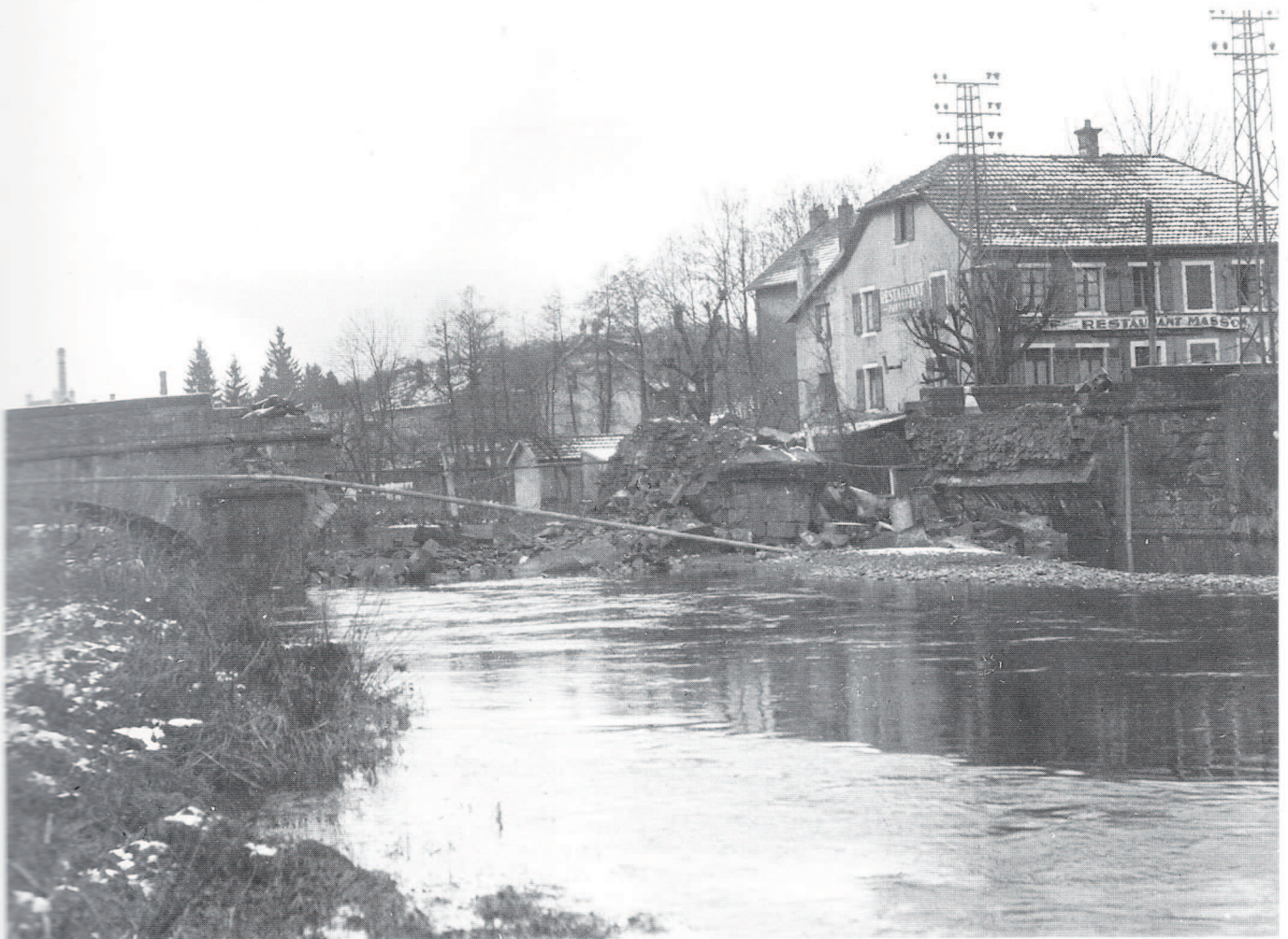
Le pont de Valdoie, détruit le 20 novembre. (Ph. Delotte Archives Municipales de Belfort)
